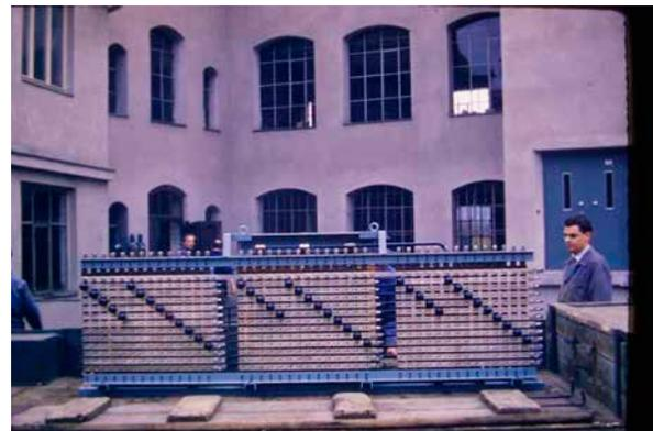
Ende der 60er-Jahre: Spezialtransformator für den Ofenbau
